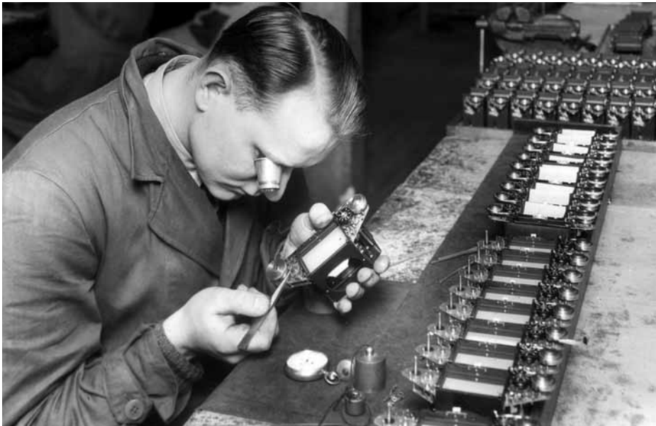
Ein Blick in die Produktion der Exakta in Dresden – hier B-Modelle mit Schalthebel bei der Montage des Langzeitknopfes und der Endkontrolle.
